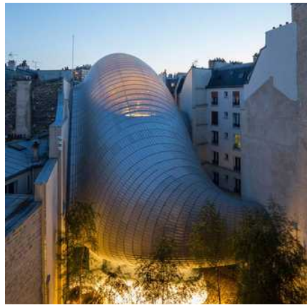
Рис. 5. Будівля благодійного фонду («Будинок-слимак») у м. Париж, Франція (2014 р.)
