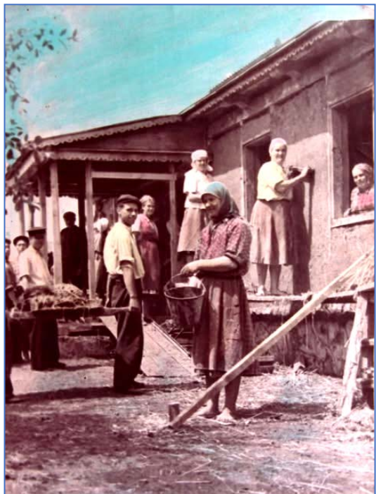
Рис. 3. Толока. Заповнення каркасу стін глиняно-солом'яним розчином. Село Немиринці, 1957 рік. (фото надано Б. Максименко)
