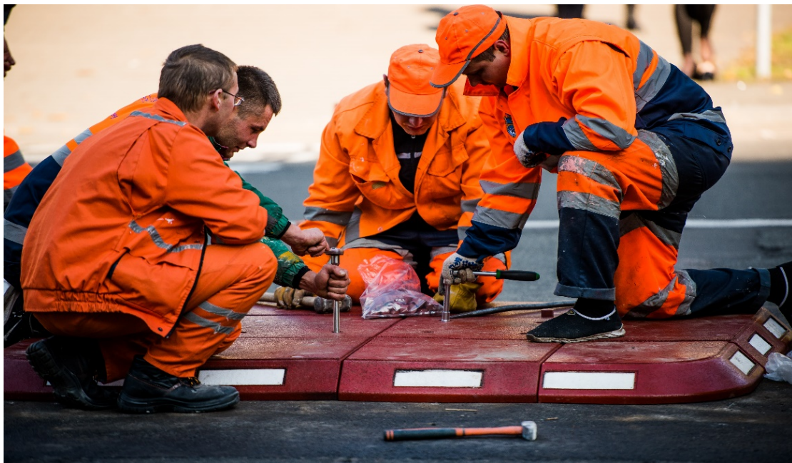
Рис. 3. Демонтаж острівця безпеки, вул. Архипенка, м. Київ
