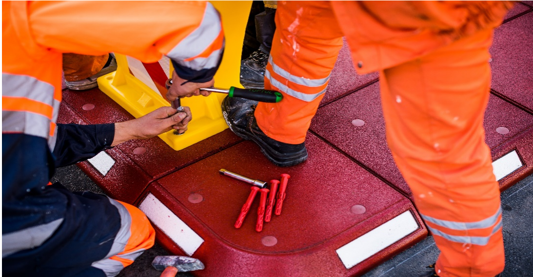
Рис. 2. Встановлення елементів модульного острівця безпеки
