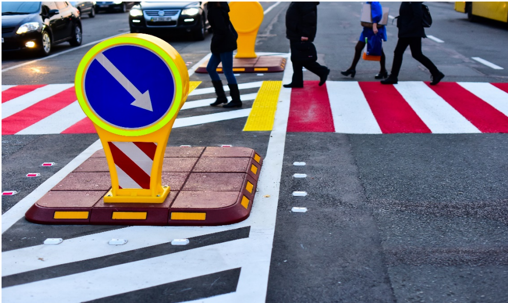
Рис. 4. Модульний острівець безпеки, вул. Архипенка, м. Київ
