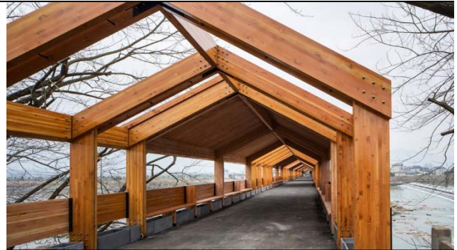
Рис. 8. Дерев'яна конструкція поверх існуючого мосту Шимень [12].
