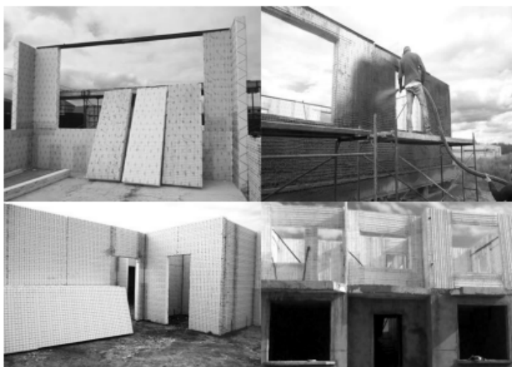
Рис. 8. Монтаж віконних та дверних отворів
