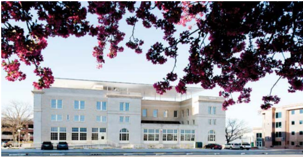
Рис. 4. Будівля суду Аспінал, Гранд-Джанкшн, Колорадо після реконструкції, 2013 р.)
