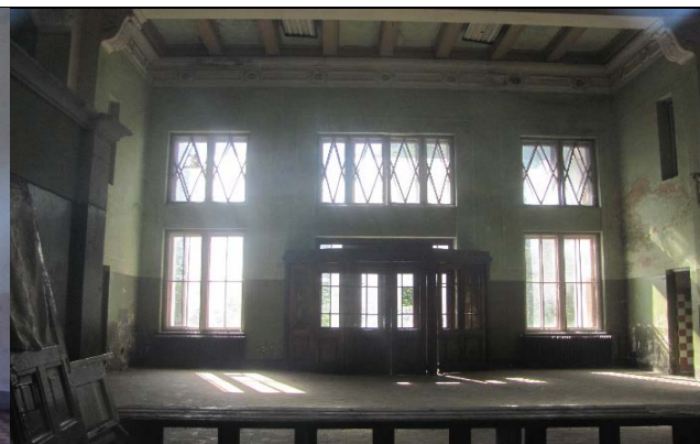
Рис.12. Інтер'єр невикористовуваного головного залу будівлі вокзалу станції Делятин, 2016 р. Фото Ю. Рочняк.
