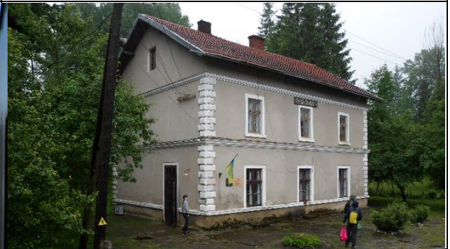
Рис.4. Будівля вокзалу станції Вороненка зі сторони перону, 2019 р. Фото Ю. Рочняк.
