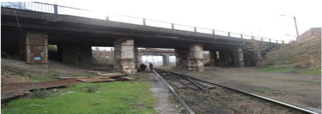
Рис. 2. Загальний вигляд шляхопроводу
