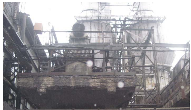
Рис. 2, б. Споруди між корпусами електролізного цеху
