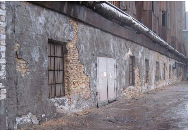
Рис. 2, а. Корпус глиноземного цеху
