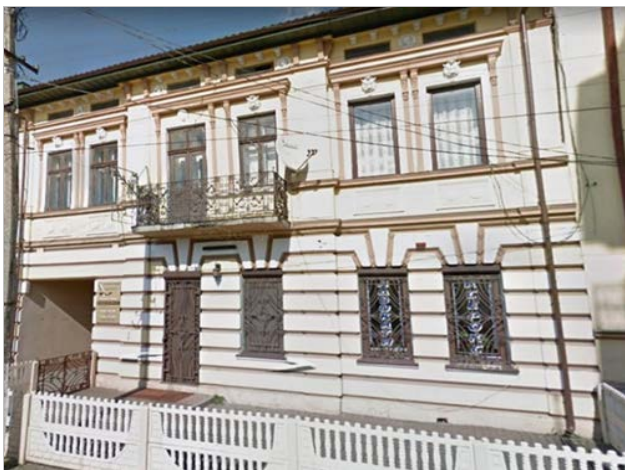
Рис.6. Житловий будинок м. Рава Руська Львівської обл. вул. Грушевського Огородження балкону, решітки.
