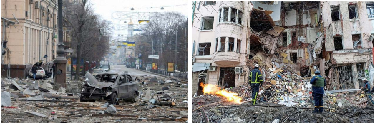
Рис. 1. Зруйнована забудова центральної частини м. Харкова, 2022 р. [12].
