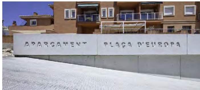
Рис. 4. Фото частини стіни фасаду вздовж заїзду у паркінг [13]
