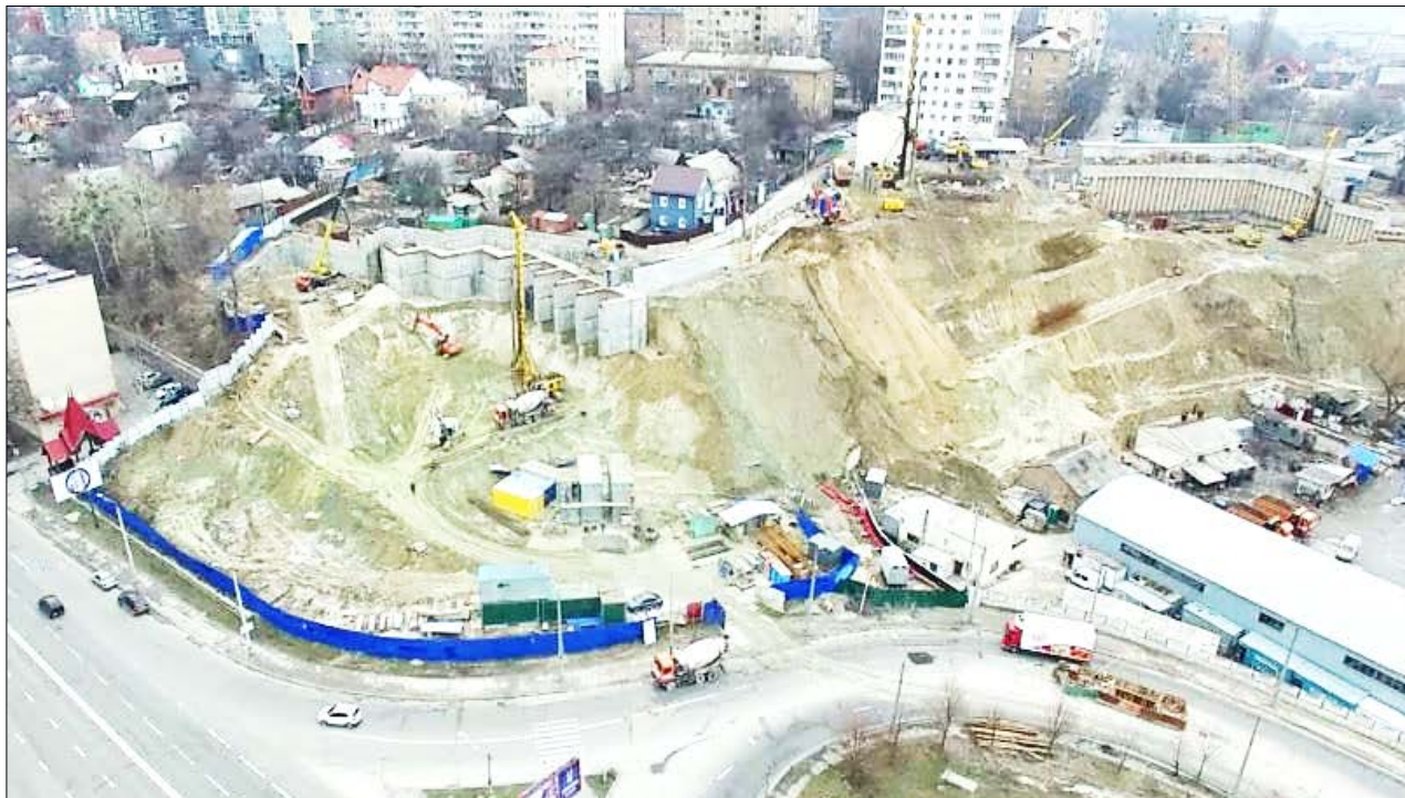
Рис. 1. Пример строительства зданий повышенной этажности на сложном рельефе – природном склоне долины р. Лыбидь, г. Киев
