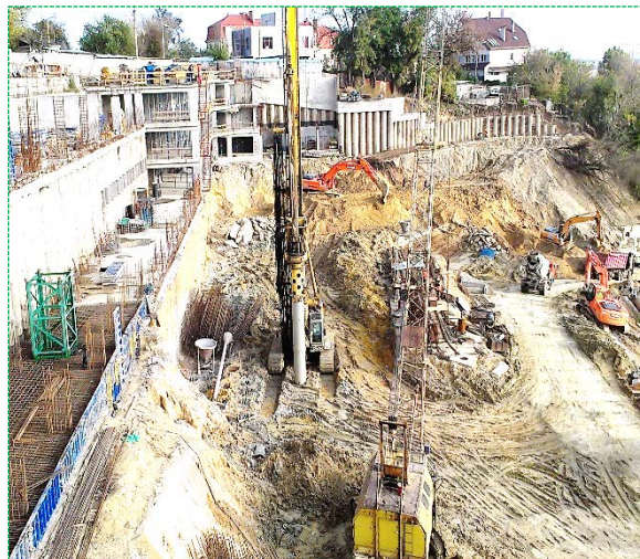
Рис. 5. Устройство буронабивных свай на уступе склона в условиях стесненности рабочей зоны по размерам в плане откосом склона и устроенной подпорной стеной (фотография авторов, г. Киев, 2016 г.)
