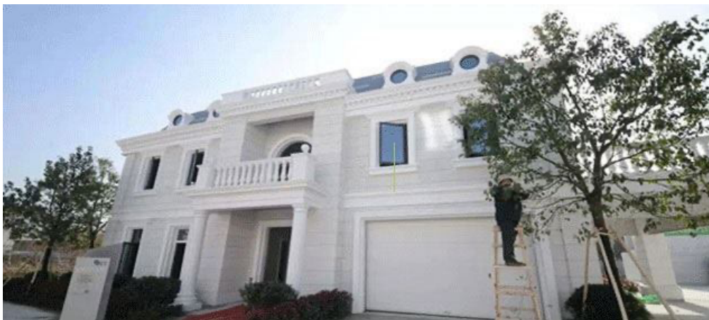
Рис. 3. Будівля, побудована компанією «WinSun» за допомогою технології 3D-друку
