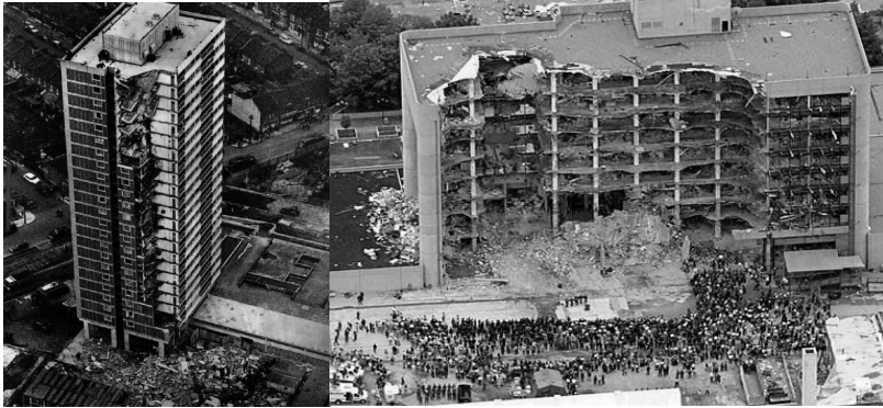
Рис.1. Прогресуюче руйнування: а) будинку «Ronan Point» в Лондоні (вибух газу); б) «Alfred P. Murrah Federal Building» в м.Оклахома (теракт)
