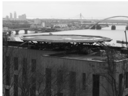
Рис.4 "Business Center " м.Київ вул. ПетраСагайдачного,11. (вид на гелікорт)
