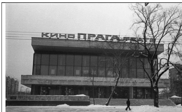
Рис.7. Загальний вигляд Кінотеатр «Прага» до реконструкції
